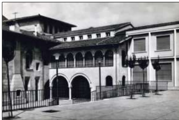
Zanano, Val Trompia: Interno Palazzo Avogadro.
