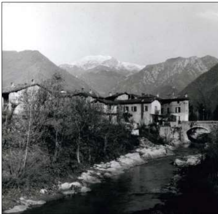
Ponte Zanano: Ingresso sul Mella.
